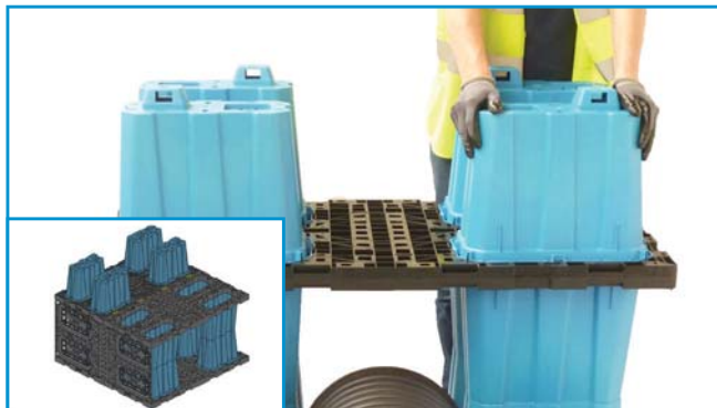
Plaatsing van de blokken op het tweede niveau
